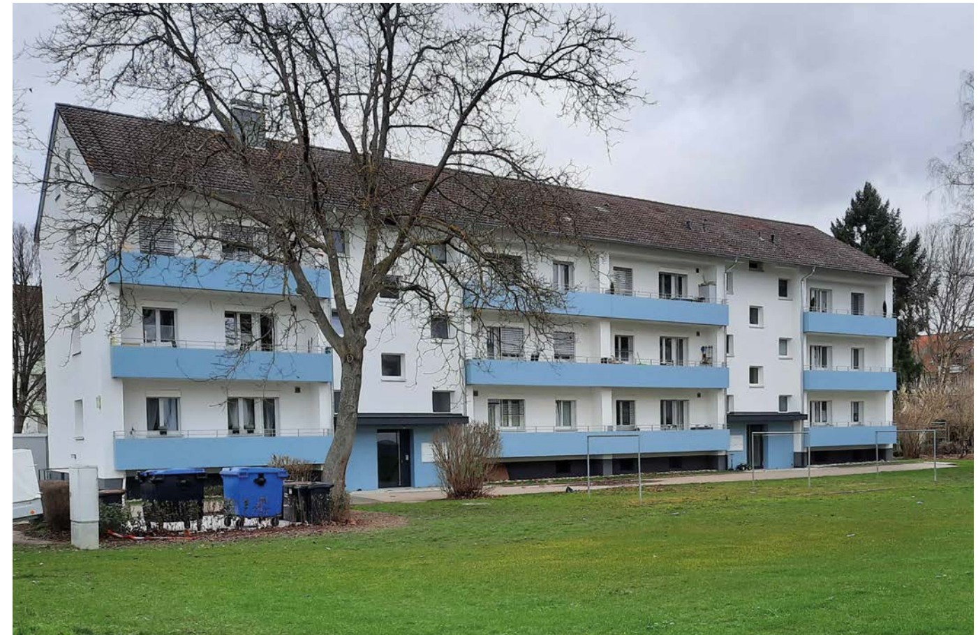
Grißheimer Weg 28, Heitersheim nach der Sanierung
