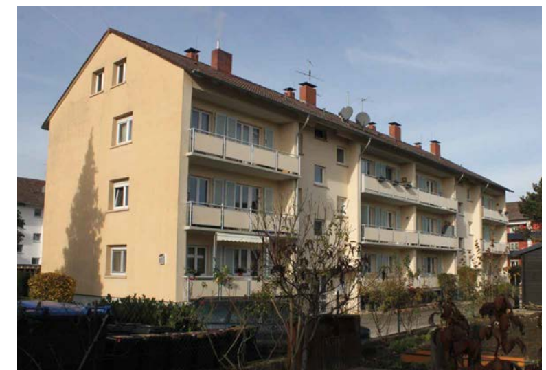
Grißheimer Weg 24, Heitersheim vor der Sanierung
