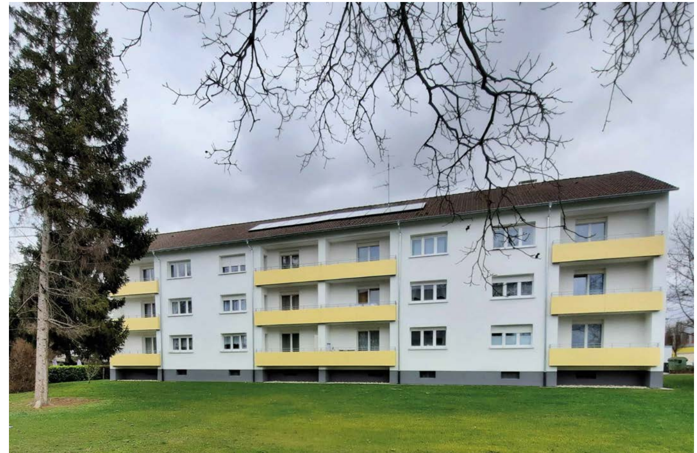
Grißheimer Weg 26, Heitersheim nach der Sanierung
